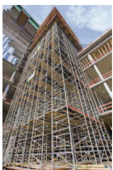
Staxo 100-Rahmen sorgen am Bauteil B für eine schnelle und sichere Unterstellung der weit auskragenden Flachdecken im Rucksackbereich.
