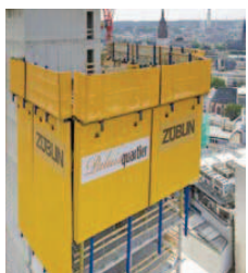
Der hydraulisch kletternde Doka-Schutzschild Xclimb 60 bietet sichere Arbeitsplätze.
