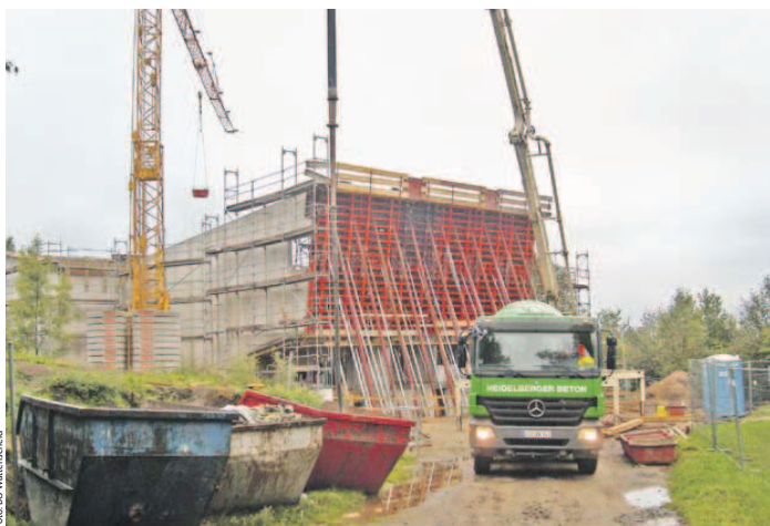
Baustellenansicht: Die Widar Schule in Bochum.
