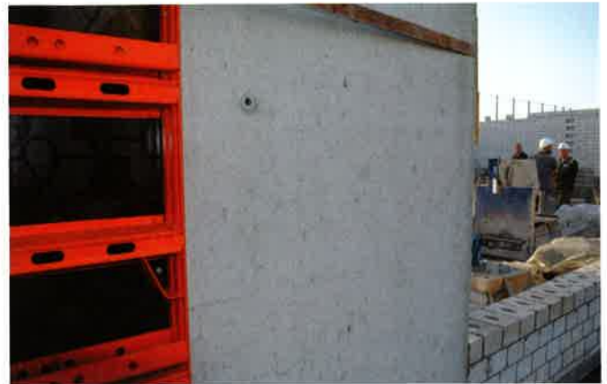
Betonoberflächen, die sich sehen lassen können: Sichtbetonqualität durch den Einsatz der Paschal Logo.3-Schalung. Foto: Elvermann
