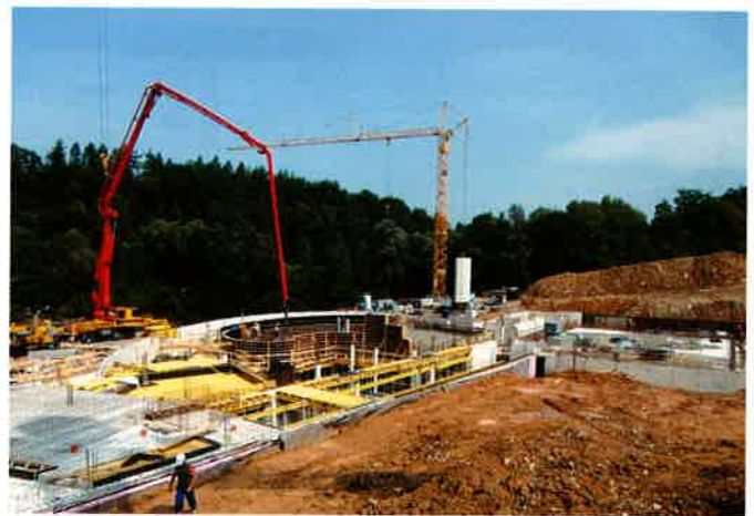
Bild 3. Termingerechert zum Badespaß: Fertigstellung im Sommer 2012 (Fotos: Elvermann)
